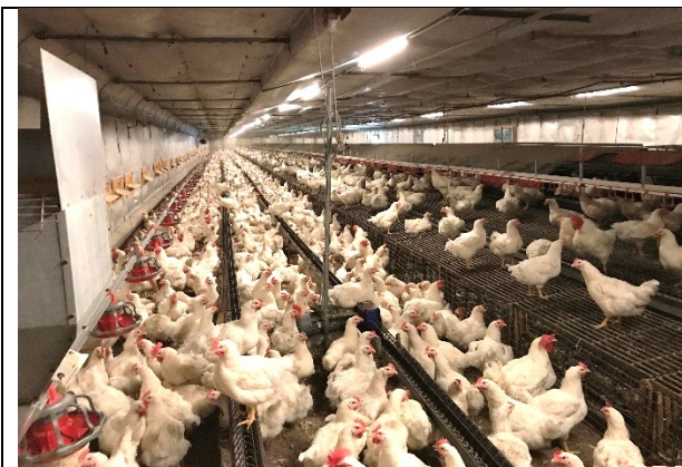
2 rijen fluorescerende lampen (40 W) boven rooster helling en eerste voerlijn.
