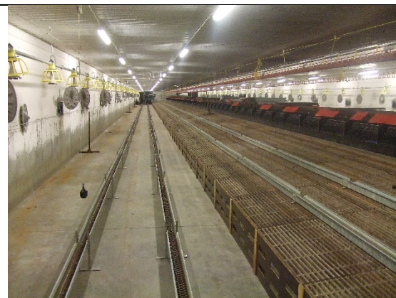
4 rijen Led verlichting boven het strooisel in een 14 m brede stal.
